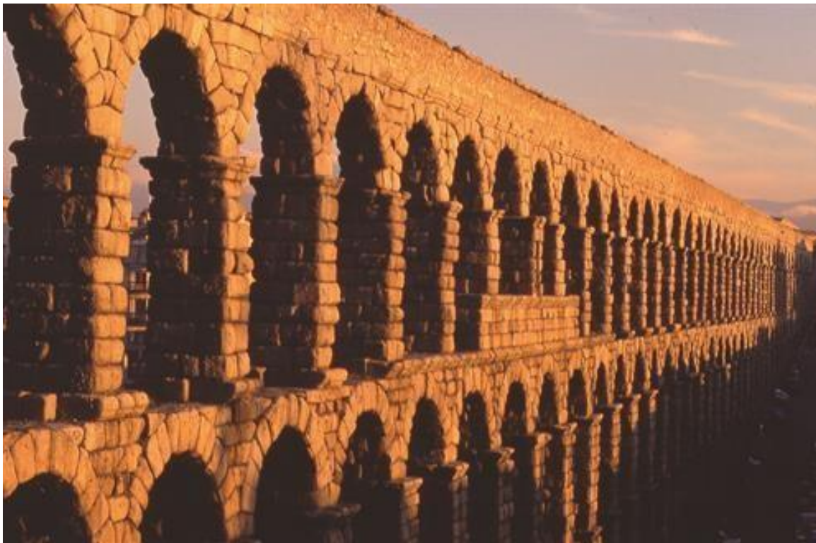
Το υδραγωγείο της Segovia
